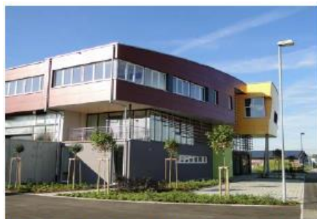
Ansicht von der Heerstraße: Das neue Gründerzentrum
